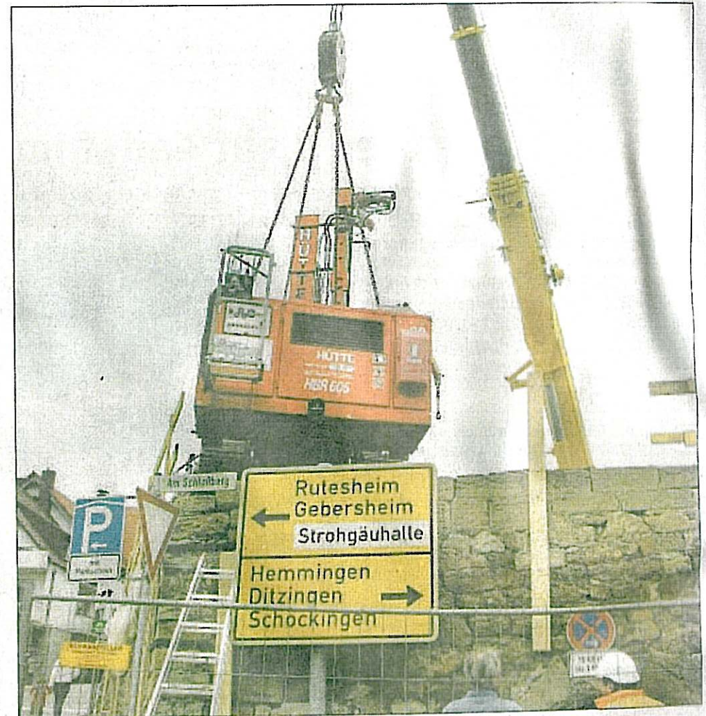
Präzisionsarbeit am Kran: halb schwebend wird an der Kurfiss-Scheune gebohrt.
